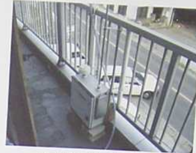
ダストモニター設置状況
